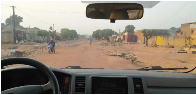
Manche Straßen sind nicht geteert und haben Schlaglöcher.
